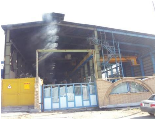
کارخانه ذوب آهن آسیا
