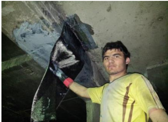
تقویت تیرهای رمپ توسط CFRP
