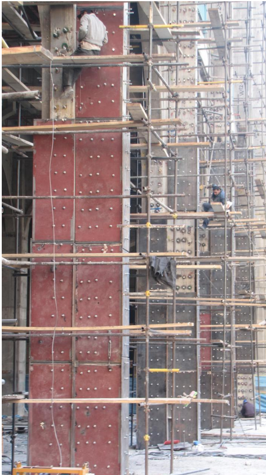
اجرای ژاکت فولادی
