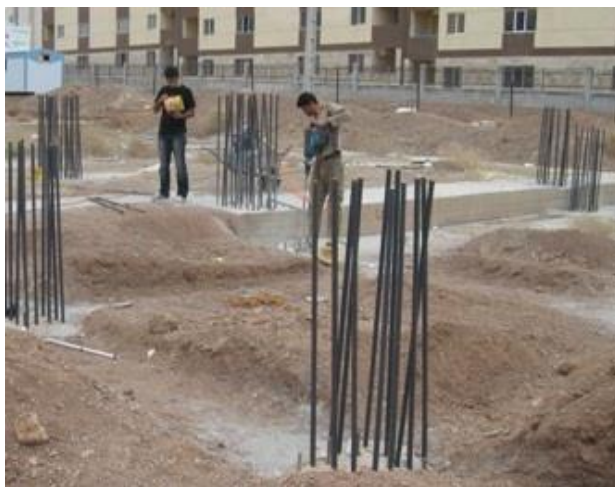
کاشت بیش از ۲۵۰۰ عدد میلگرد نمره ۲۵ به عمق ۶۰ سانتیمتر جهت ریشه انتظار ستون
