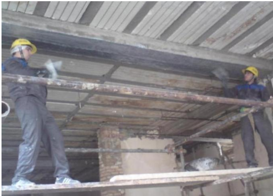
اجرای FRP SikaWrap-200C جهت قويت تیرها
