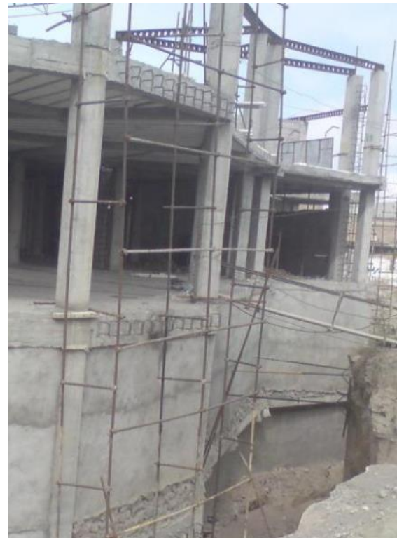
اجرای کاشت آرماتور در تیرها جهت الحاق دیوار برشی پیرامونی به سازه
