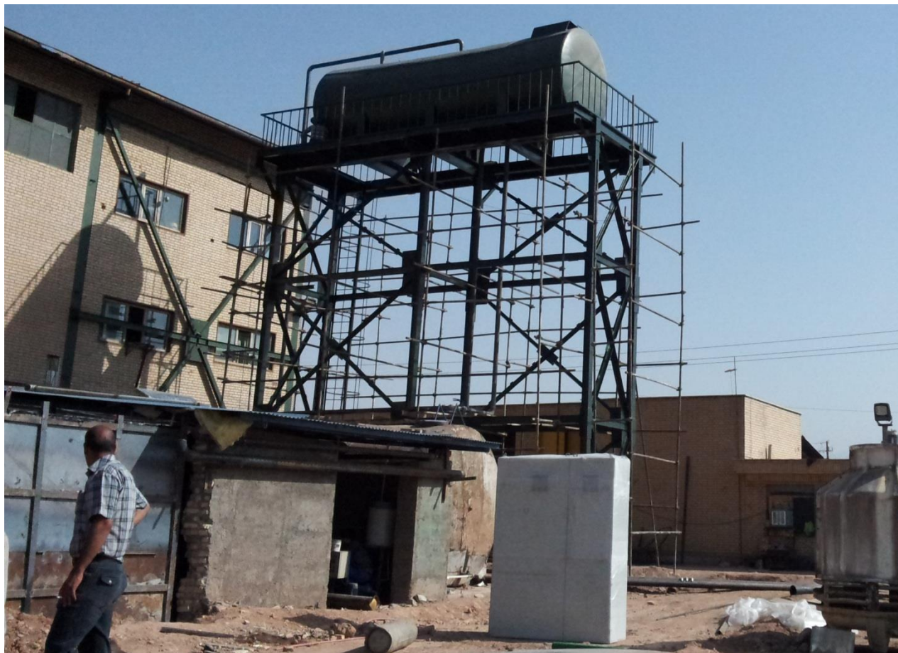
افزودن بادبند به قاب سوله
