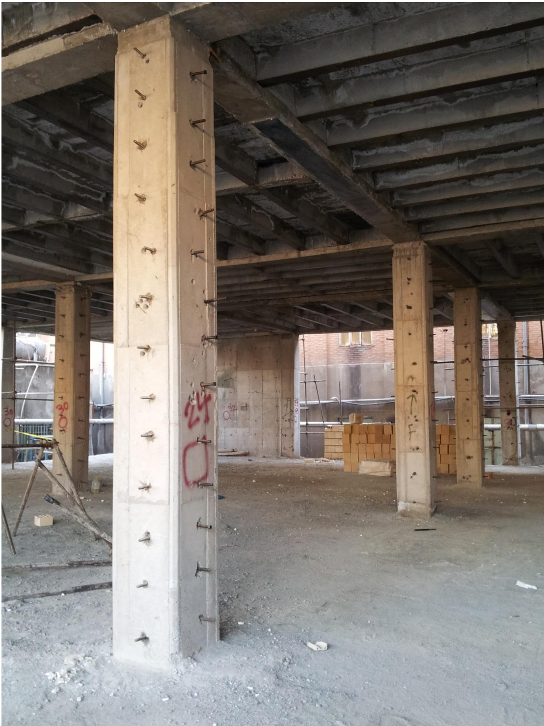
کاشت بولت روی ستون برای نصب ورق فولادی
