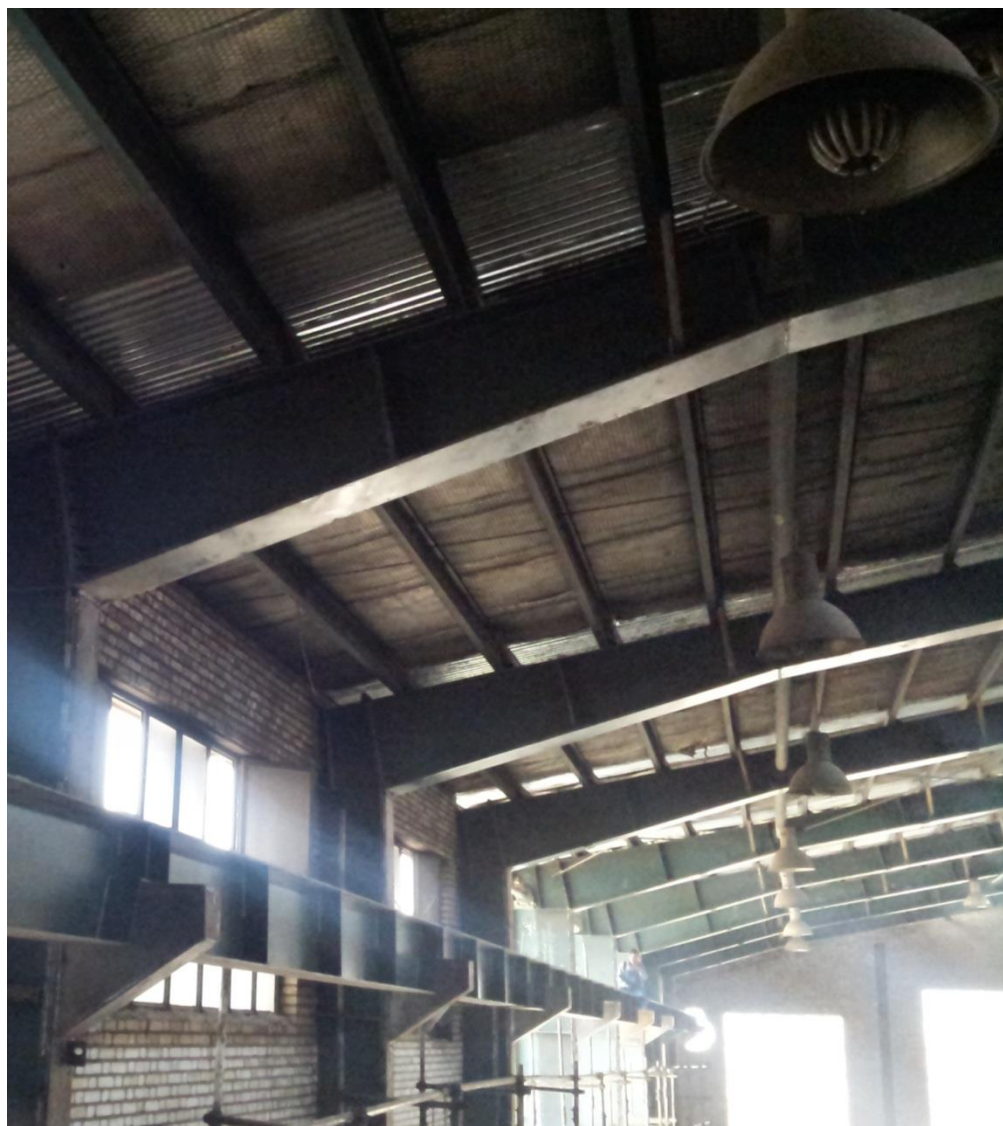
طراحی کربل ها برای تحمل بار جرثقیل جدید ۲۰ تنی
