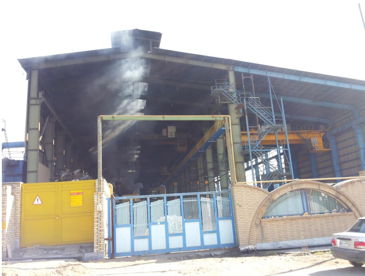
کارخانه ذوب آهن آسیا
