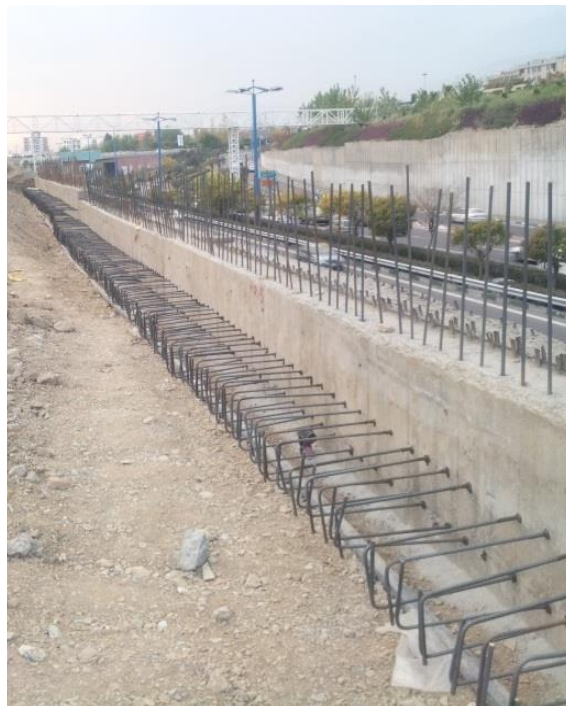
کاشت میلگرد ریشه فونداسیون و دیوار حائل در بتن
