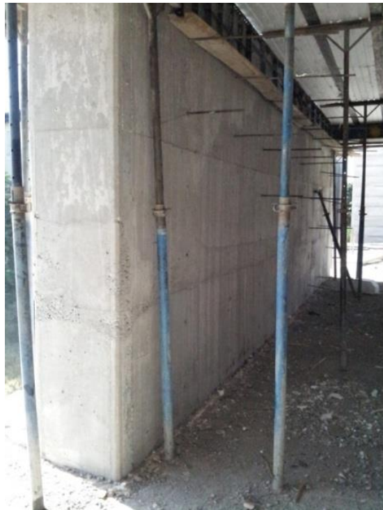
اجرای دیوار برشی
