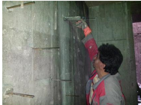
کاشت آرماتور جهت تقویت دیوار حائل
