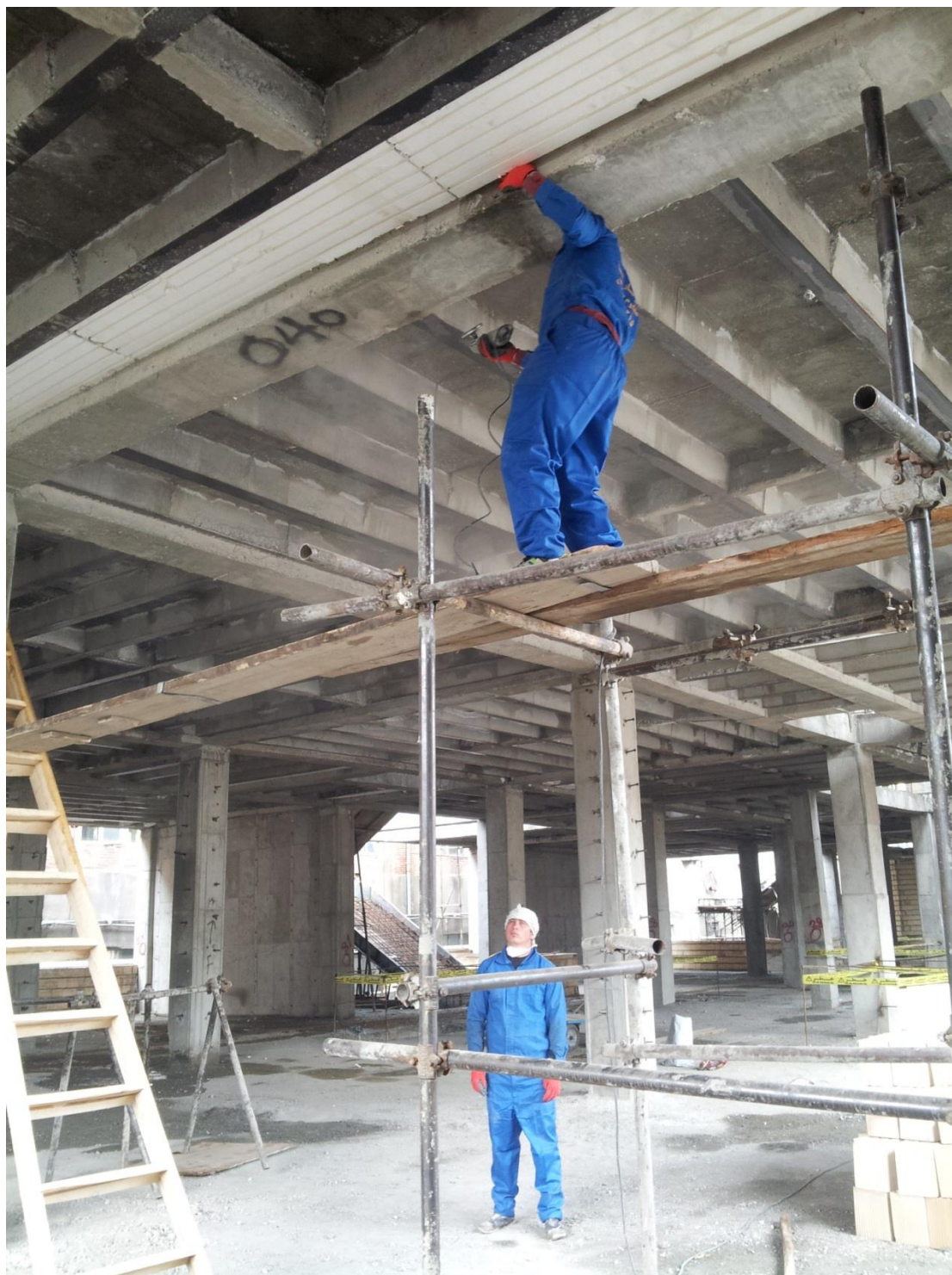
آماده سازی جهت نصب FRP
