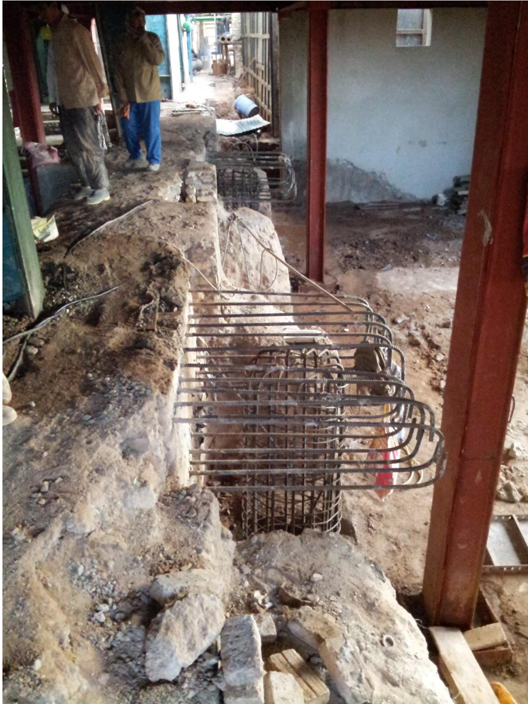
تقویت فونداسیون موجود سوله با افزودن شمع
