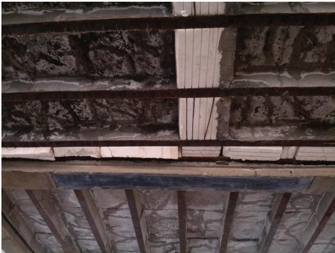
نصب FRP زیر تیرها
