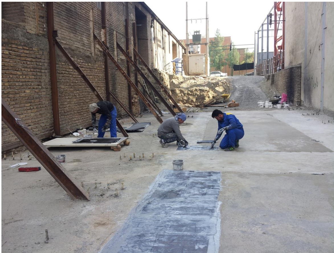
نصب FRP روی فونداسیون برای تامین میلگردهای فوقانی فونداسیون
