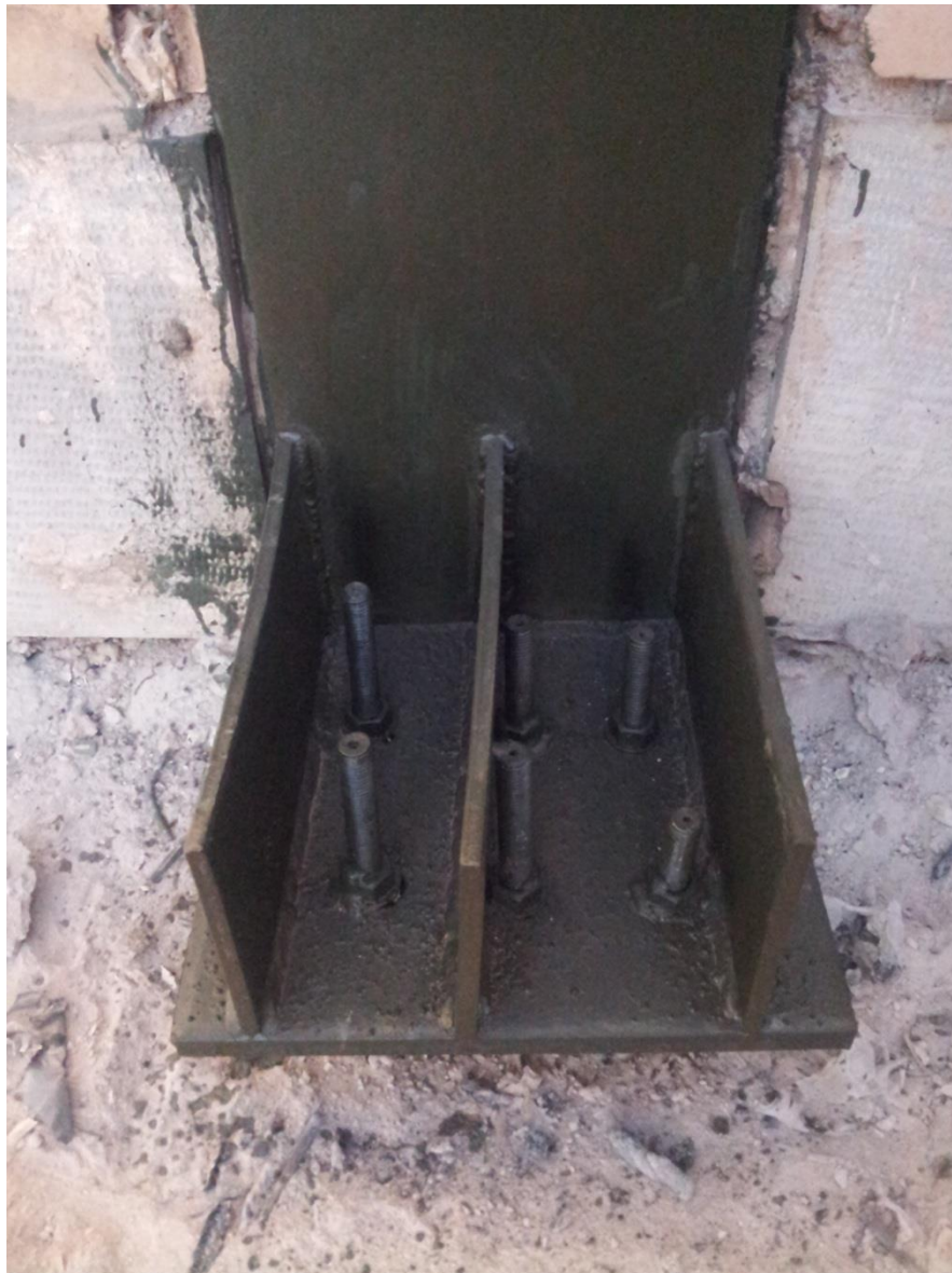
تقویت صفحه ستون ها توسط بولت ها و استیفرهای جدید
