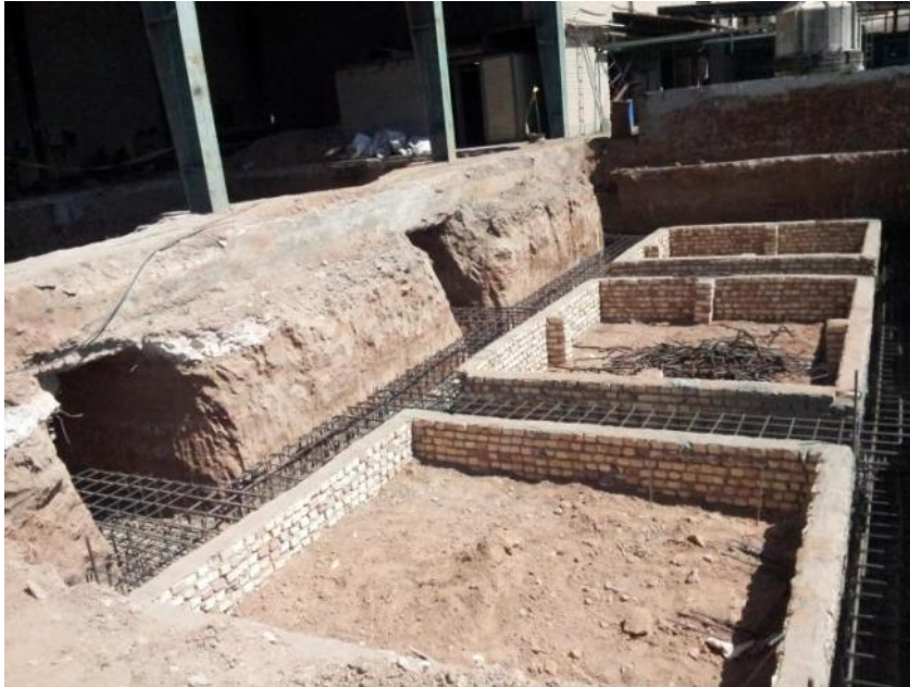
فونداسيون اتاق کوره کارخانه ذوب آهن آرمان آسيا
