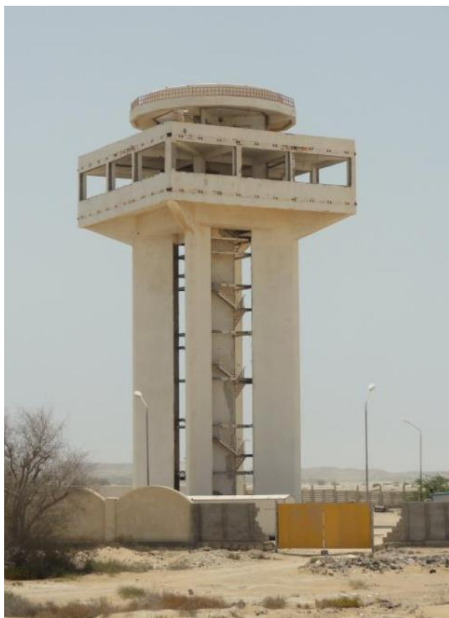
پس از وقوع زلزله
