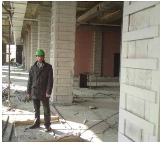
اجراى ژاكت فولادى
