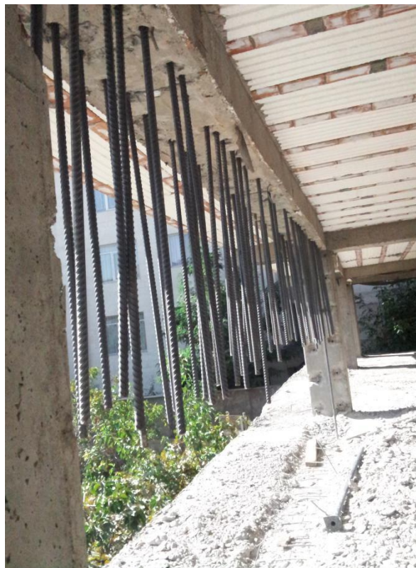
سوراخکاری راه به در و کاشت میلگرد
