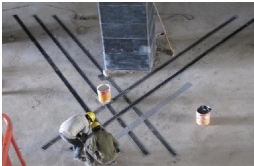
اجرای لمينيت جهت كنترل لنگرهای منفی و خيز دال
