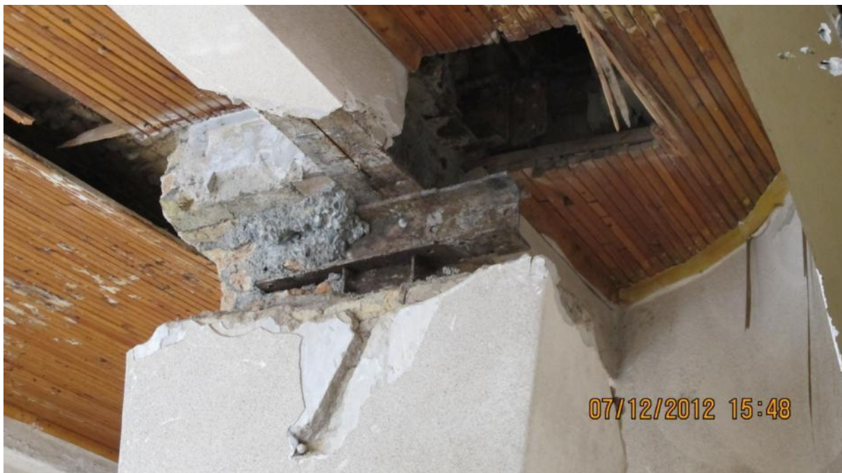
اتصال تیر به ستون در محل سونداژ
