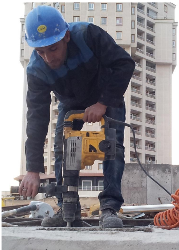
سوراخکاری در بتن
