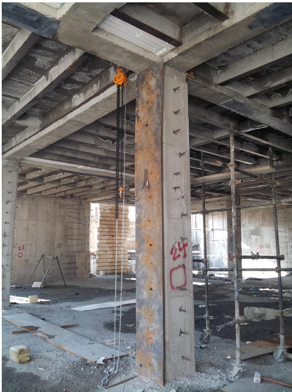
تقویت ستونها به روش ژاکت فولادی
