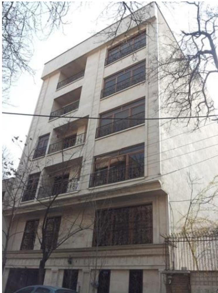
ساختمان مسکونی لنگرود
