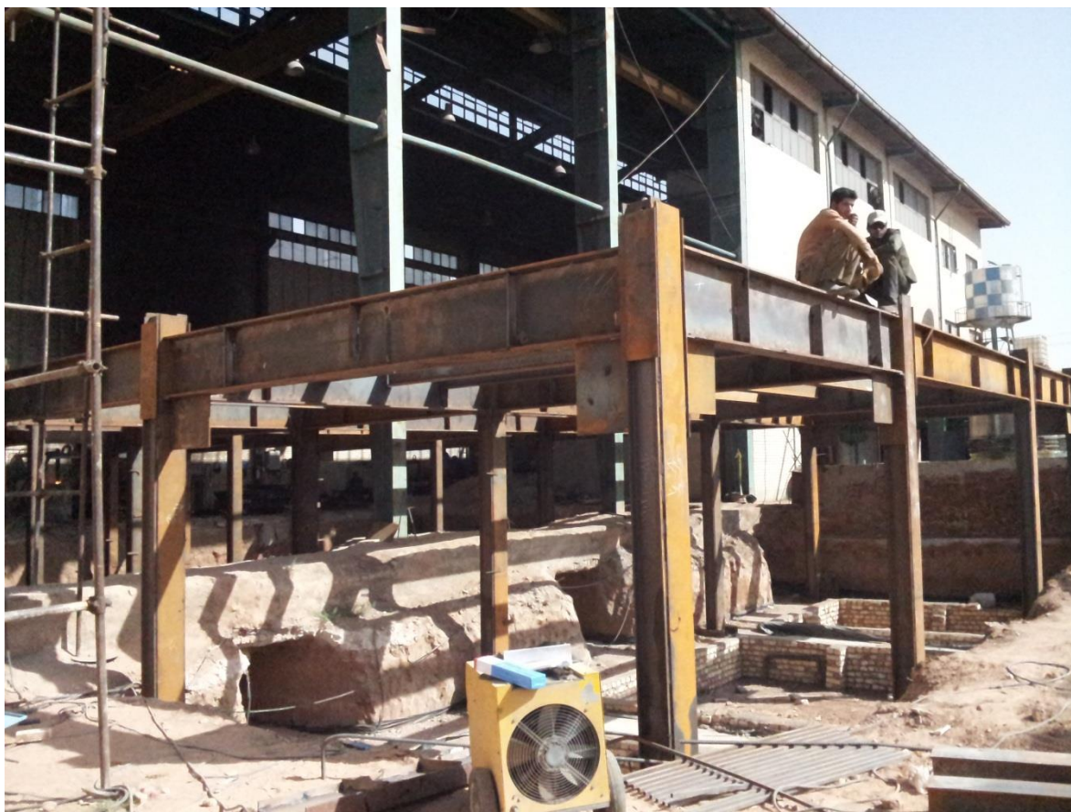
طراحی اتاق کوره جدید برای تحمل سربار دیپوی قراضه به وزن ۱۰ تن بر متر مربع
