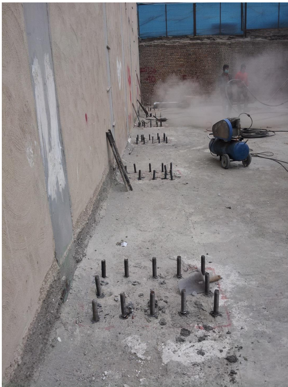
کاشت بولت برای نصب صفحه ستون های جديد
