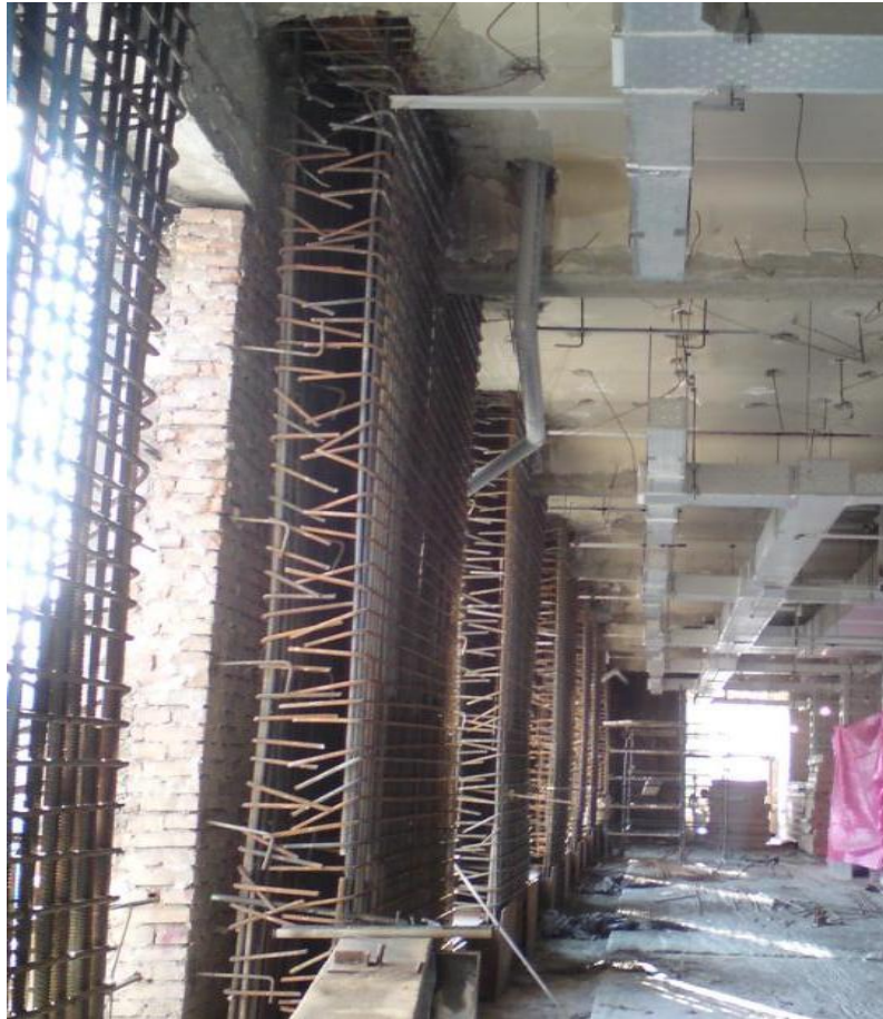
اجرای دیوار برشی جدید درون دال
