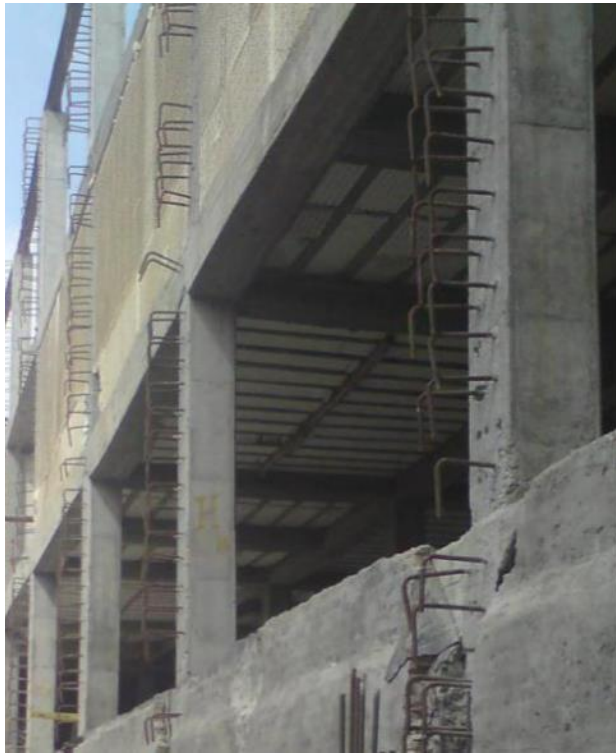
اجرای کاشت آرماتور جهت الحاق ستون جدید به ستون موجود
