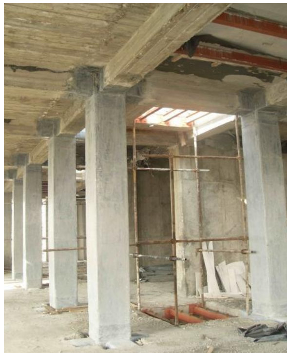
تقویت خمشی ستون
