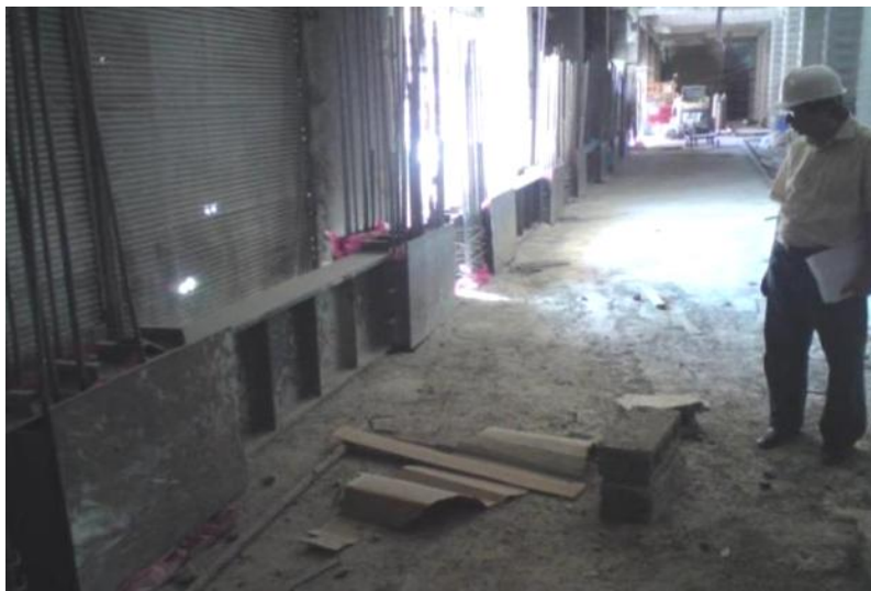
اجرای تیرهای همبند فلزی
