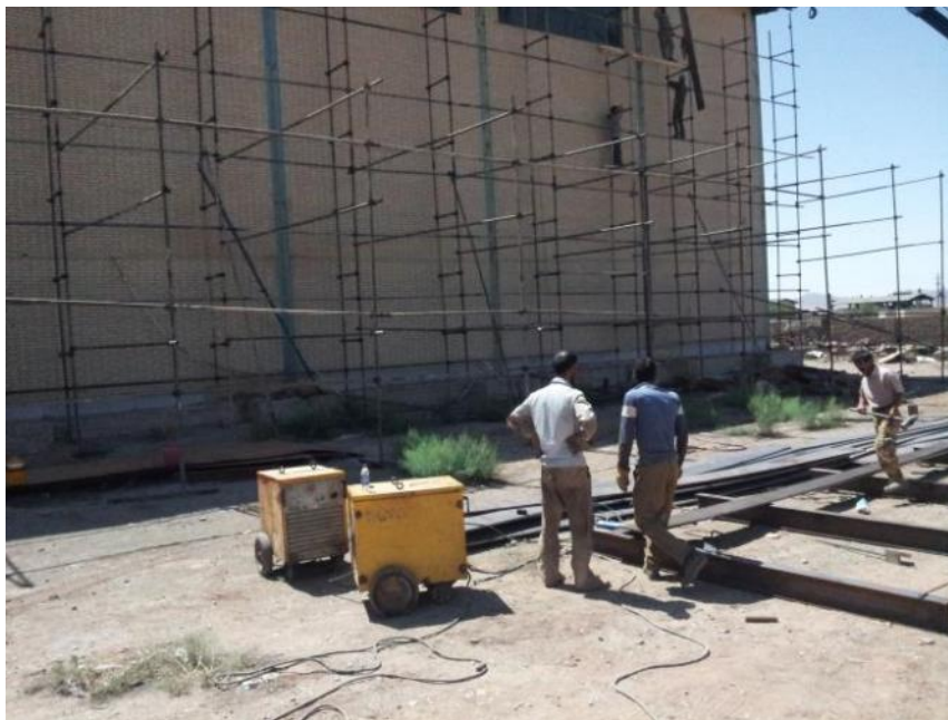
تقويت ستون های سوله کارخانه ذوب آهن آرمان آسيا
